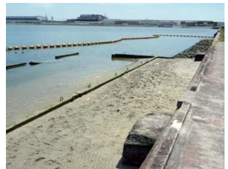
生物共生型護岸（堺2区）
