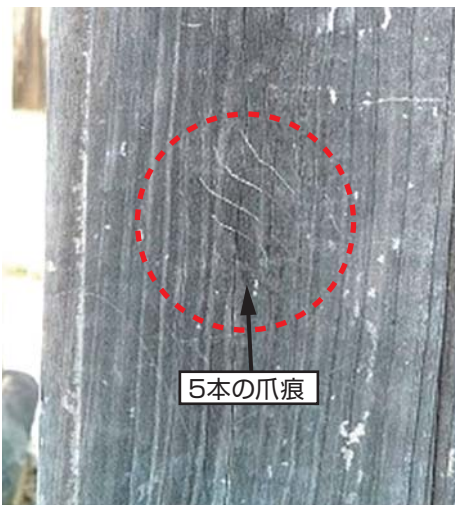
寺の柱に残されたアライグマによる痕跡
