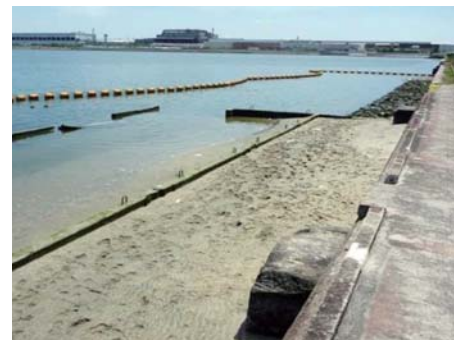
生物共生型護岸（堺2区）
